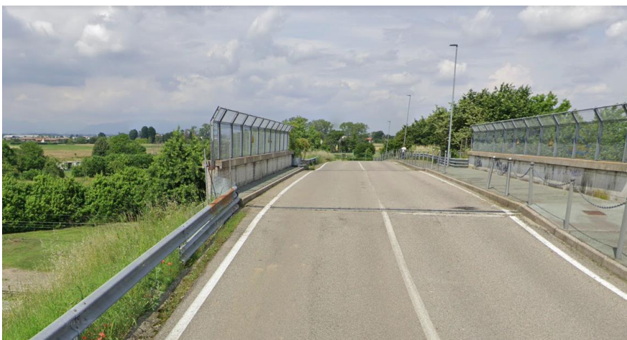
Figura 223. Vista del sovrappasso alla ferrovia di viale Rezia
