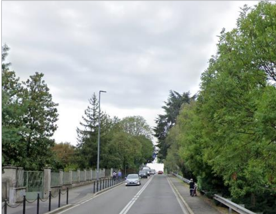
Figura 80. Restituzione fotografica Via Volonterio
