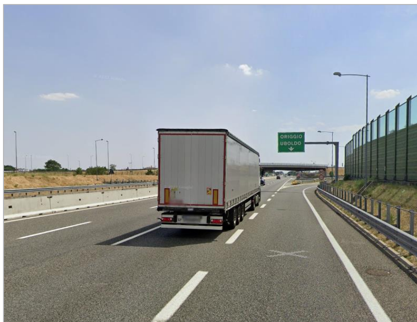
Figura 71. Restituzione fotografica dello svincolo di Origgio Uboldo in A9
