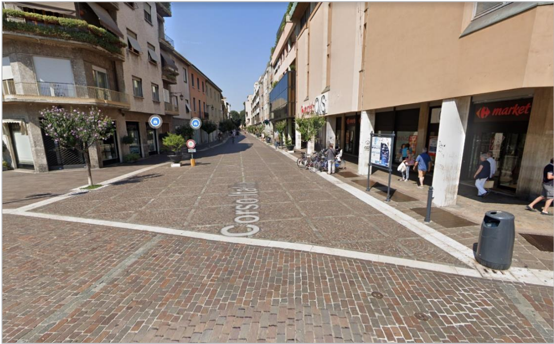
Figura 148. Sbarramento presente in Piazza Libertà verso Corso Italia
