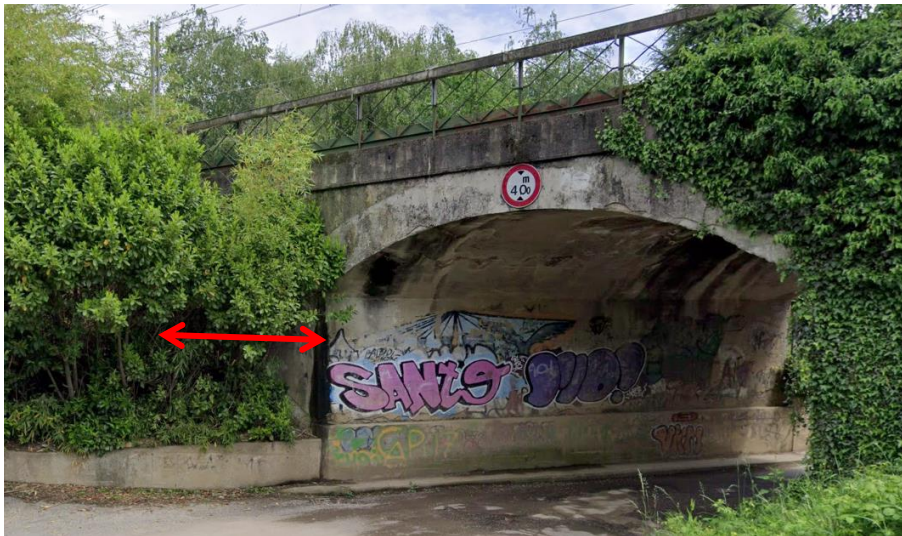
Figura 226. Vista del sottopasso alla ferrovia su via Giovanni XXIII
