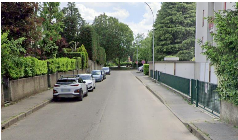
Figura 227. Vista del sottopasso alla ferrovia su via Giovanni XXIII
