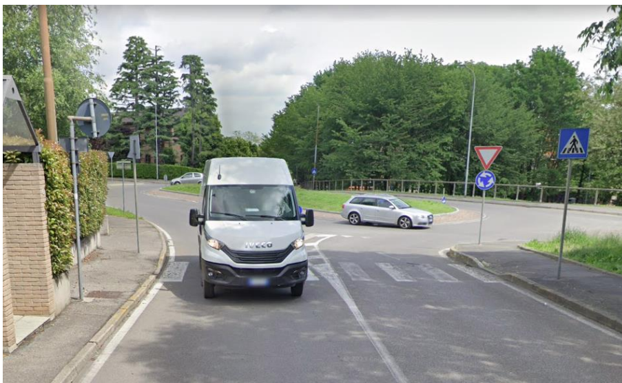
Figura 229. Vista dell'innesto di via Padre Agostino Gemelli sulla rotatoria sulla SP30
